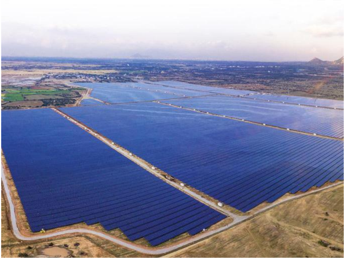
Ảnh 1. Một nhà máy điện mặt trời lớn ở tỉnh Ninh Thuận.
